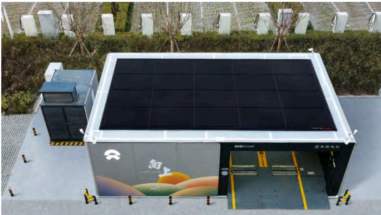
▲ 隆基绿能与蔚来合作的首座HPBC（HYBRID PASSIVATED BACK CONTACT，复合钝化背接触）光伏换电站
